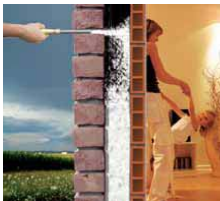
Insuflada desde el exterior
